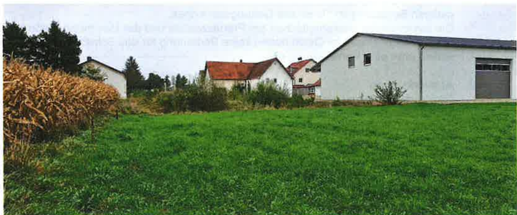
Abb. 5: Neu gebaute Halle ohne Eingrünung im Osten des Geltungsbereichs
