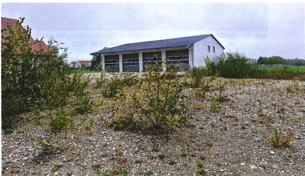
Abb. 3: Offene Kiesflächen mit Sukzessionsstadien und Neophyten auf den Grundstücken der abgerissenen Bebauung im Ostteil des Geltungsbereiches am 23.09.2025
