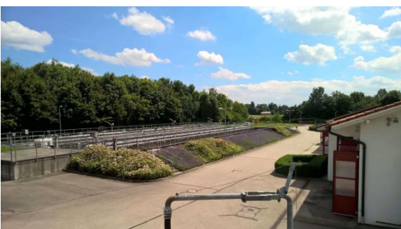
Abb. 2: Drei parallel laufende Belebungsbecken
