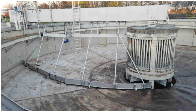
Abb. 6: Das Nachklärbecken kurz vor dem Abschluss der Sanierungsarbeiten
