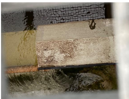
Abb. 3: Bretterwand für den Klarwasserablauf
