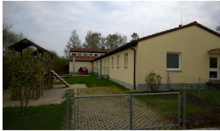
Kindergarten Wolkenschlößchen, Tassiloweg 5
