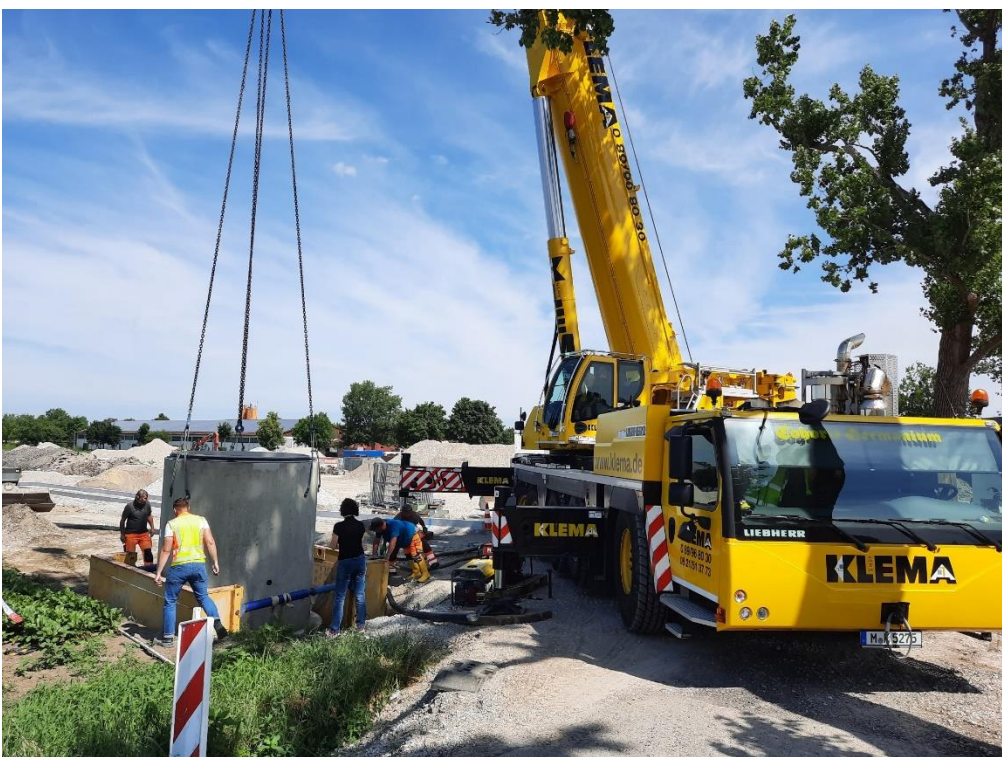
Einheben des neuen Pumpwerkes
