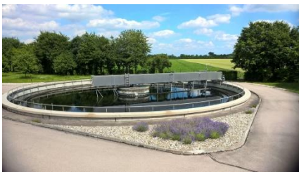
Abb. 1: Schaut doch eigentlich ganz gut aus das Nachklärbecken – doch der Schein trügt
