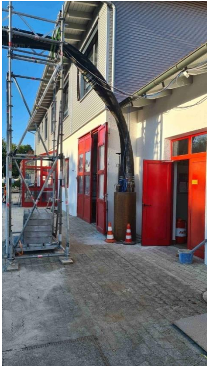
Abb. 5: Der Sammeltrichter für die Rücklaufschlammleitung von den Belebungsbecken über dem Rücklaufschlammloch.
