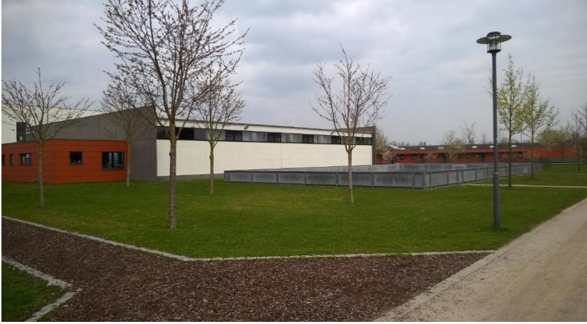
Stock- und Bogenschützenhalle
