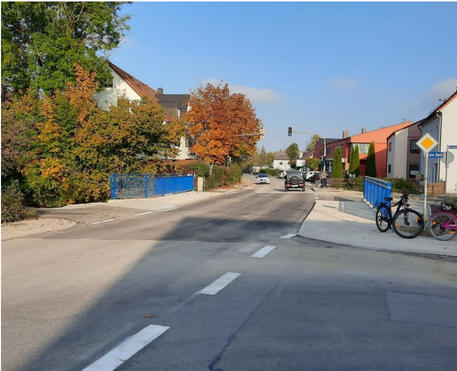
Neue Brücke im Oktober 2022
