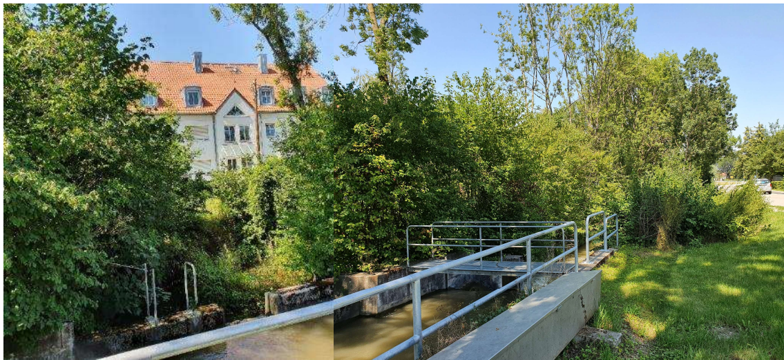
Abb. 5: Wehranlage an der Goldach nördlich der Ludwigstraße
