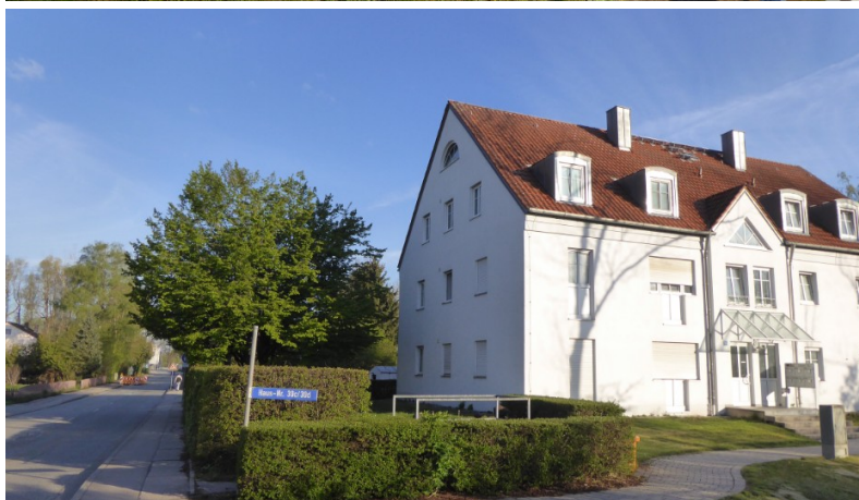
Abb. 7: Gebäude im Südosten des Gebietes, westlich der Goldach
