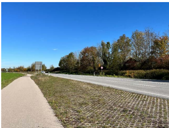
Abbildung 4: Fuß-/Radweg entlang der B301 (Foto PSLV, Oktober 2022)
